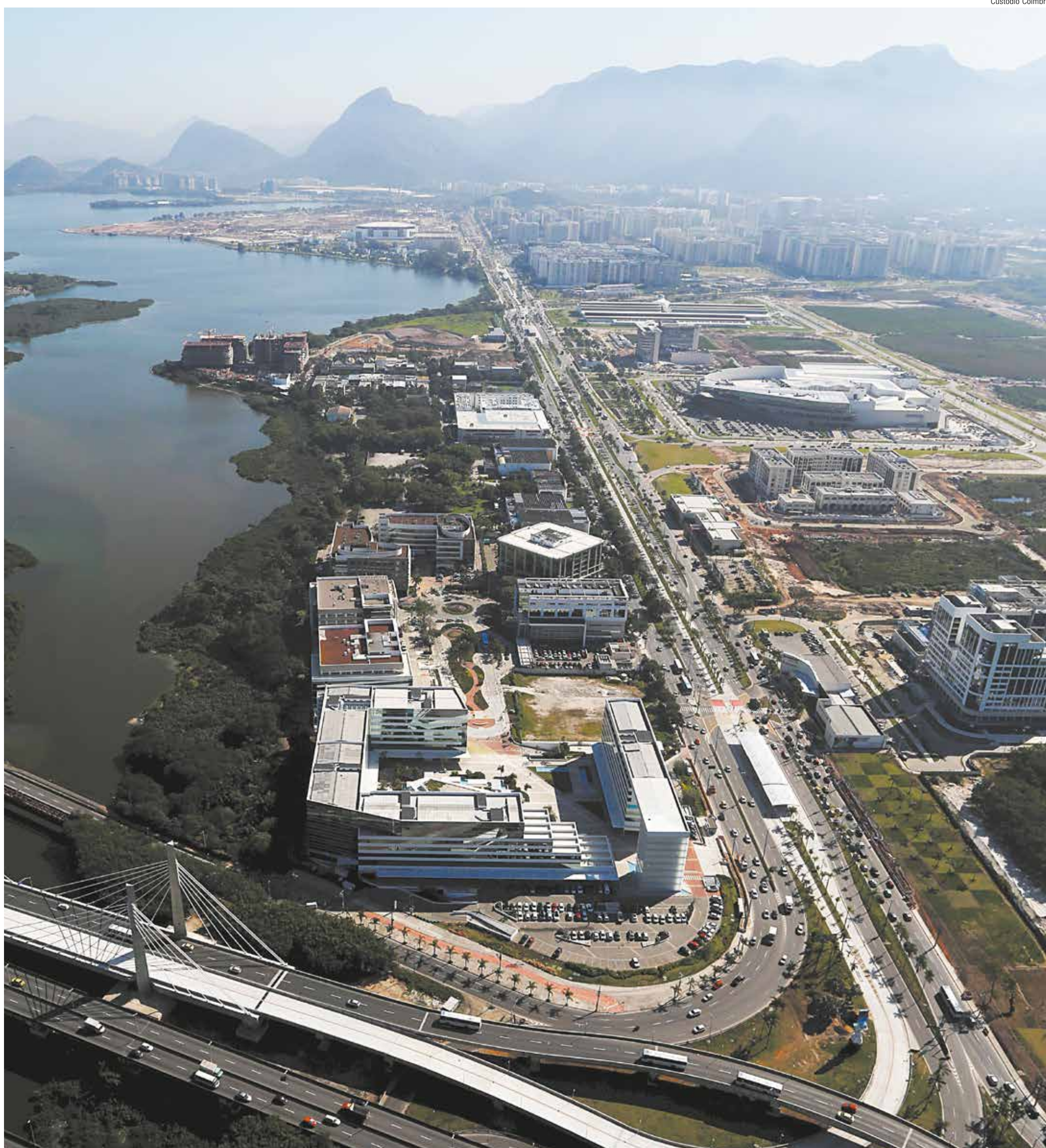
Vista aérea da ponte estaiada Cardeal Eugênio Salles, no Transcarioca. Ao fundo, a região da Avenida Abelardo Bueno, que vem recebendo o maior fluxo dos investimentos em infraestrutura da cidade
