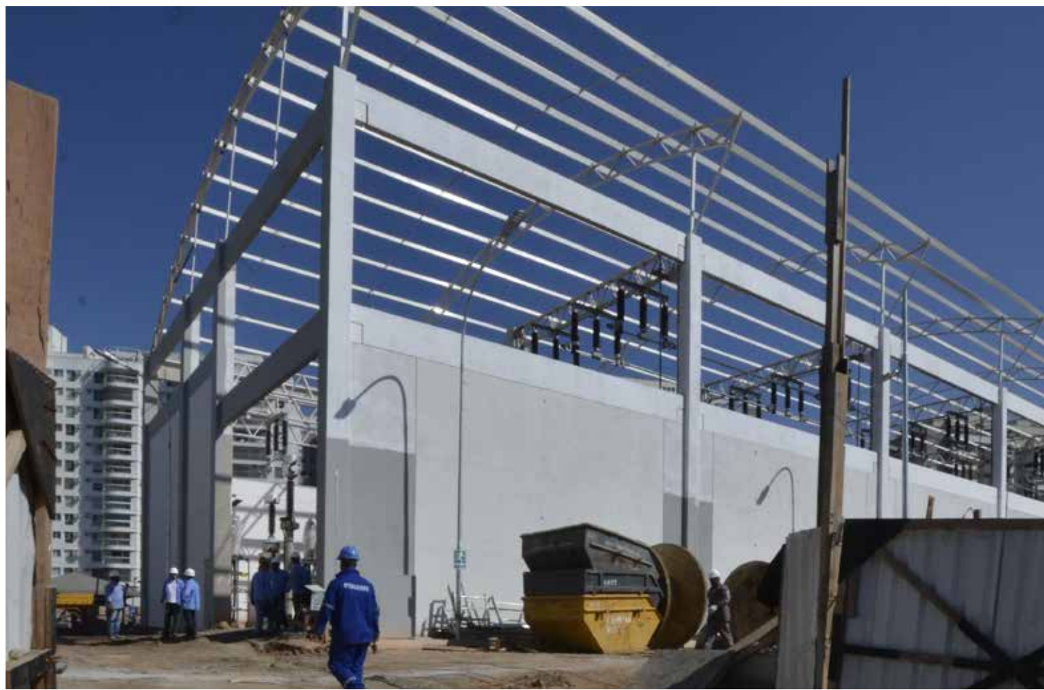
A subestação Gardênia está em fase final de construção. De lá partirá o principal ramal subterrâneo de alimentação da subestação Olímpica
